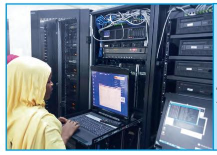
Dispositif de Monotoring installé par la Haute Autorité de la Communication Audiovisuelle (HACA) du Maroc «HMS». Il permet de faire le suivi de 16 télévisions et 34 radios.
